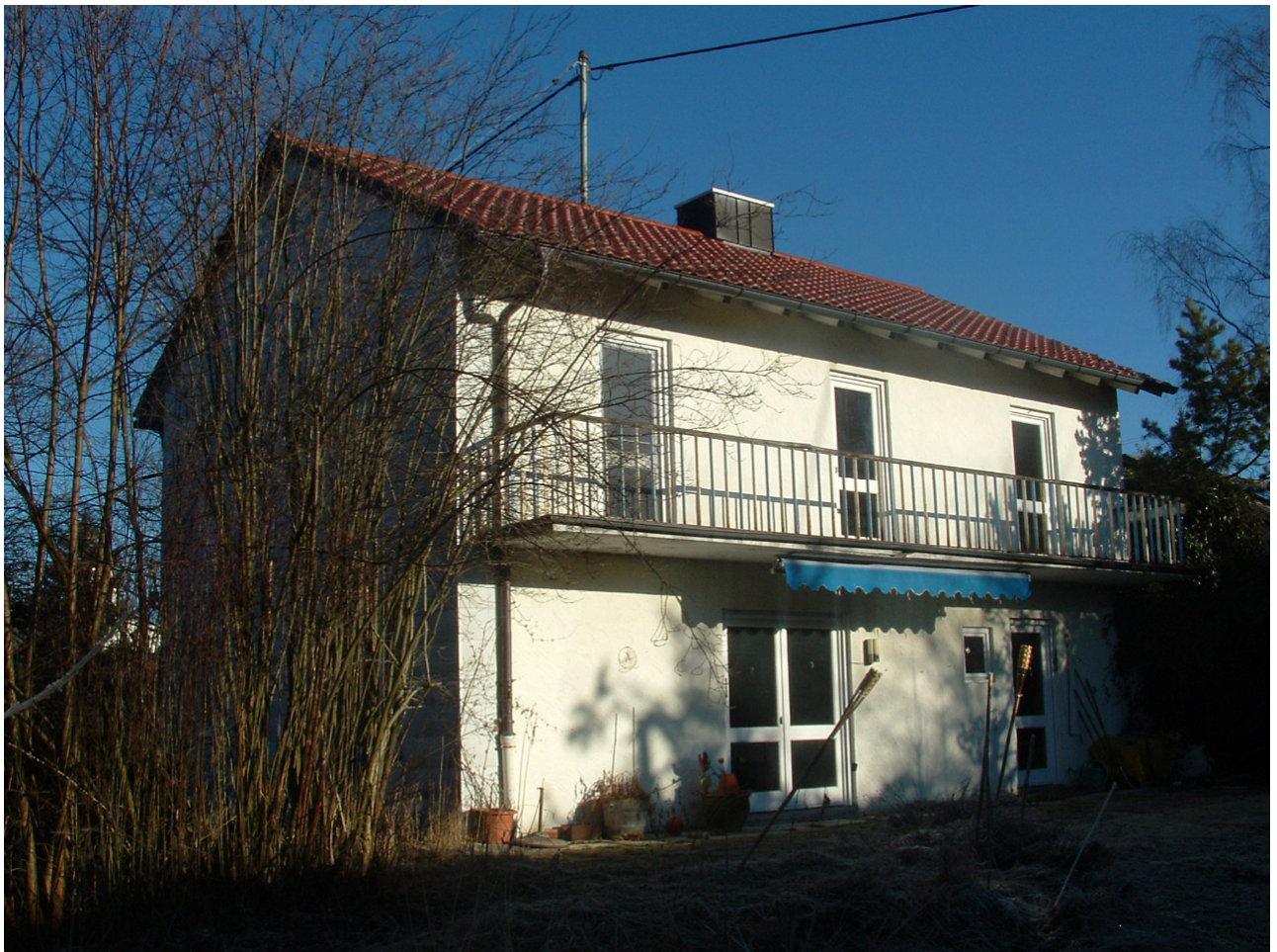
Gebäude vor der Sanierung
